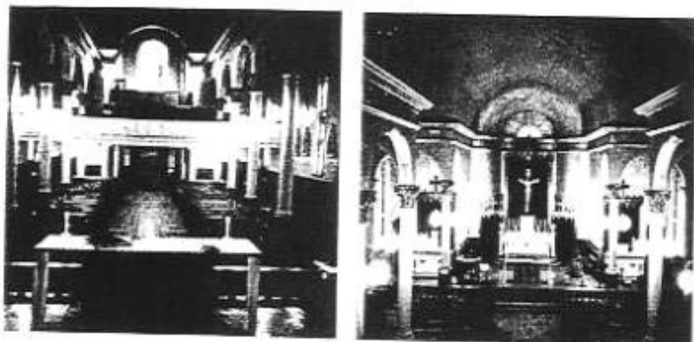
Avant la rénovation
